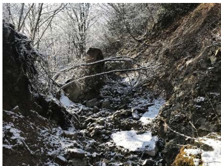
崩落した林道
